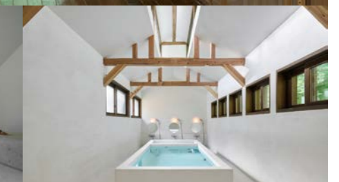
浴室(大):既存トイレ棟はサッシから上の部材を再利用
