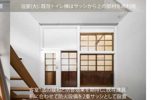
浴室(大):既存トイレ棟はサッシから上の部材を再利用
