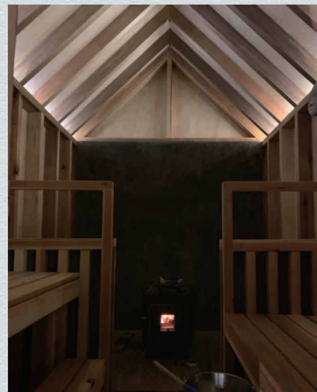
サウナ小屋内観 採光・換気のための軒スリットに照明が仕込まれている。
