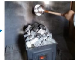
サウナストーンに少しずつ水をかけ、蒸気(ロウリュ)を発生させます。室内の温度を上げたいときは、ロウリュを足します。あまりたくさん水をかけると下の鉄板に水が落ちてはねるため、少しずつ水をかけます。
