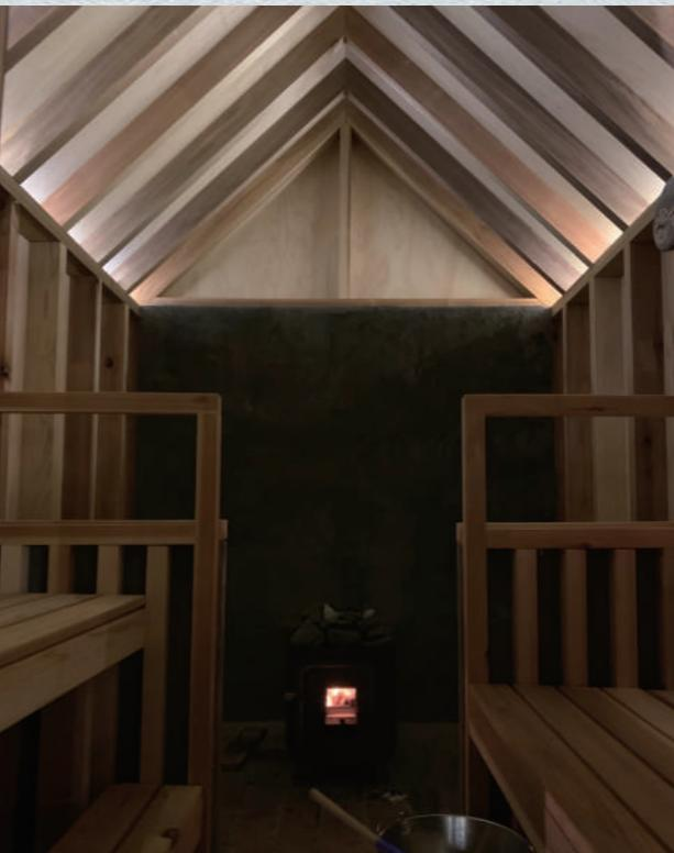
サウナ小屋内観 採光・換気のための軒スリットに照明が仕込まれている。
