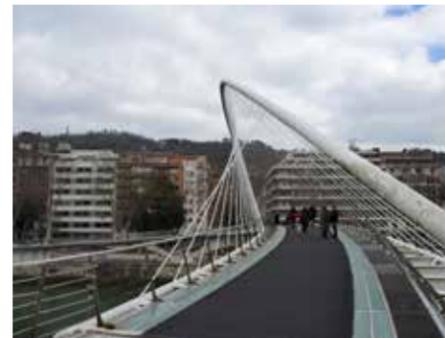
カラトラバ橋 異なる角度のアーチから成る構造体が両端を支える吊り橋
