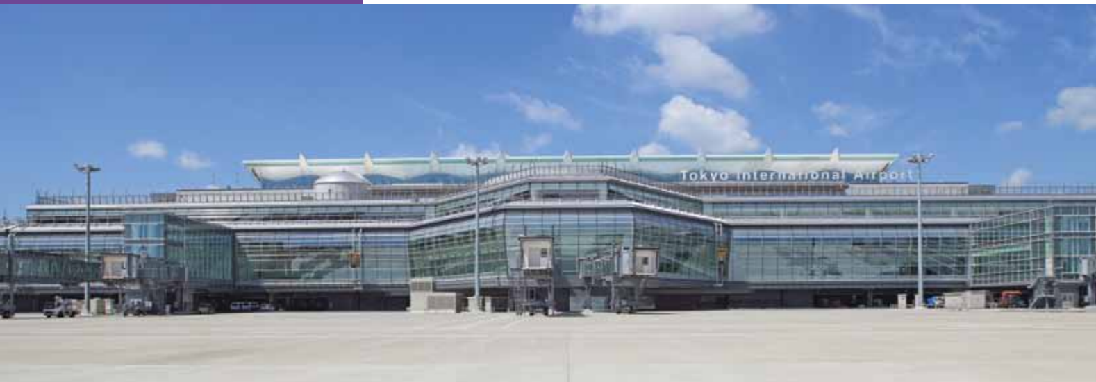
東京国際空港国際線旅客ターミナルビル外観
