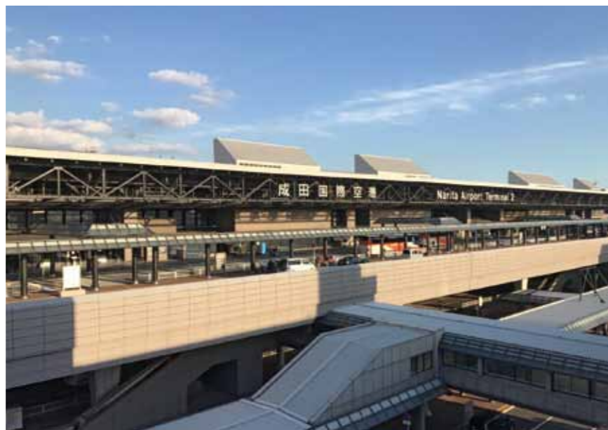
成田国際空港第 2 旅客ターミナルビル外観
