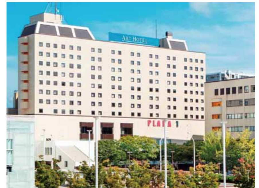
新潟駅南口第一地区再開発事業
