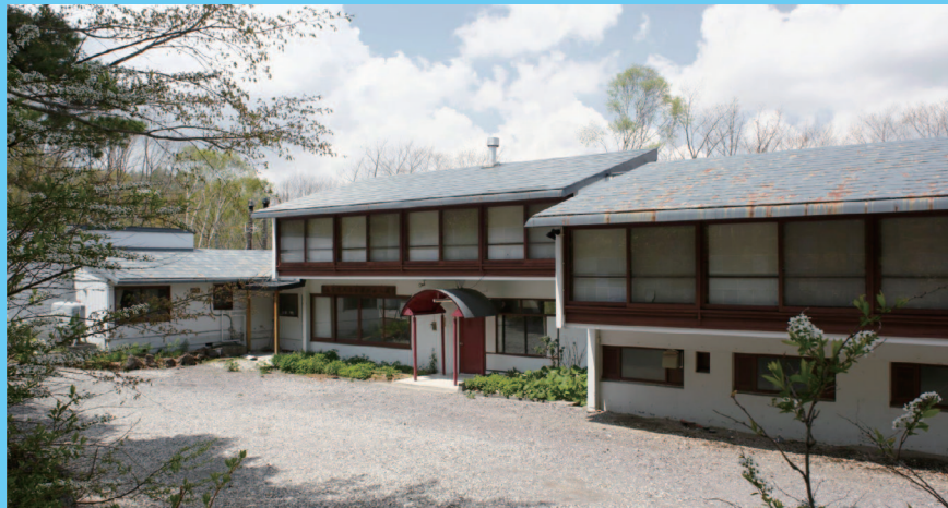
減築前の全景
