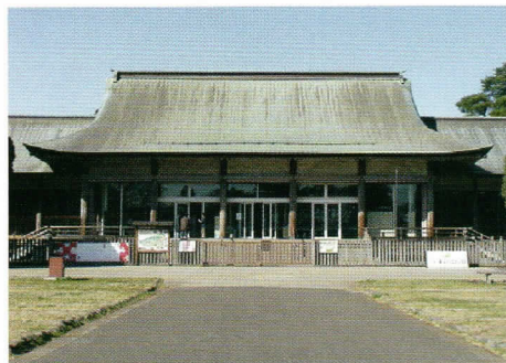
江戸東京たてもの園旧光華殿耐震補強
