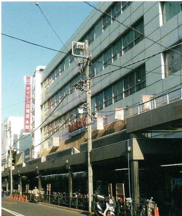
奥並びに新館増築工事中のダイシン百貨店
