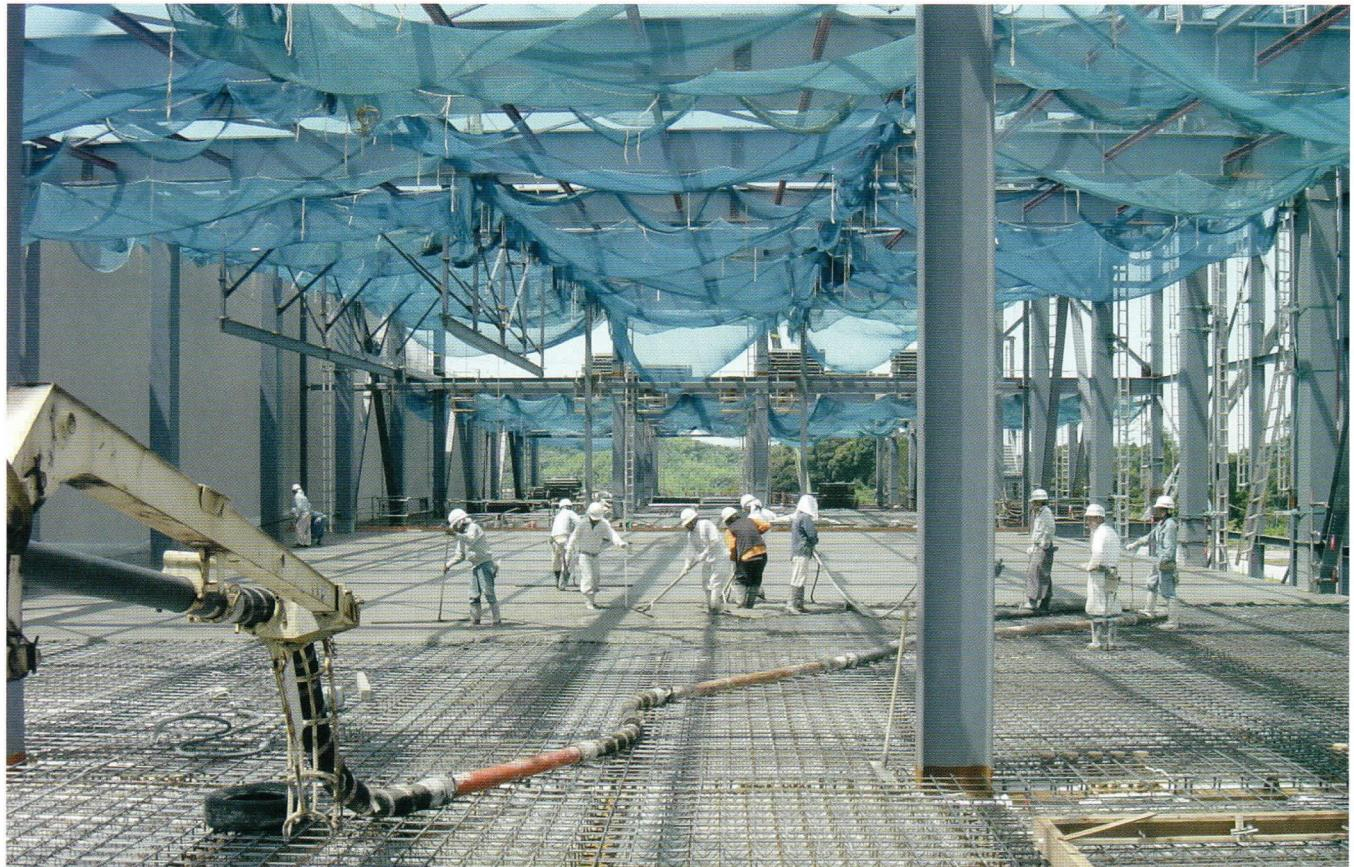
(株)サンエー化研掛川工場 2階スラブコンクリートの打設状況
