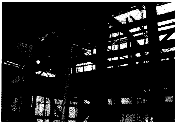
上2点：現在、大島氏が手がけている茅葺き民家の復元・保存工事。
