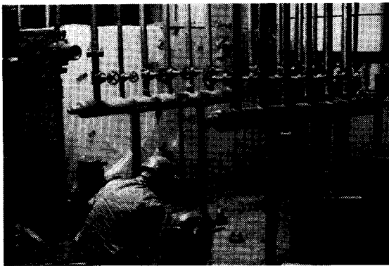
第2代実験システム(工事中)
