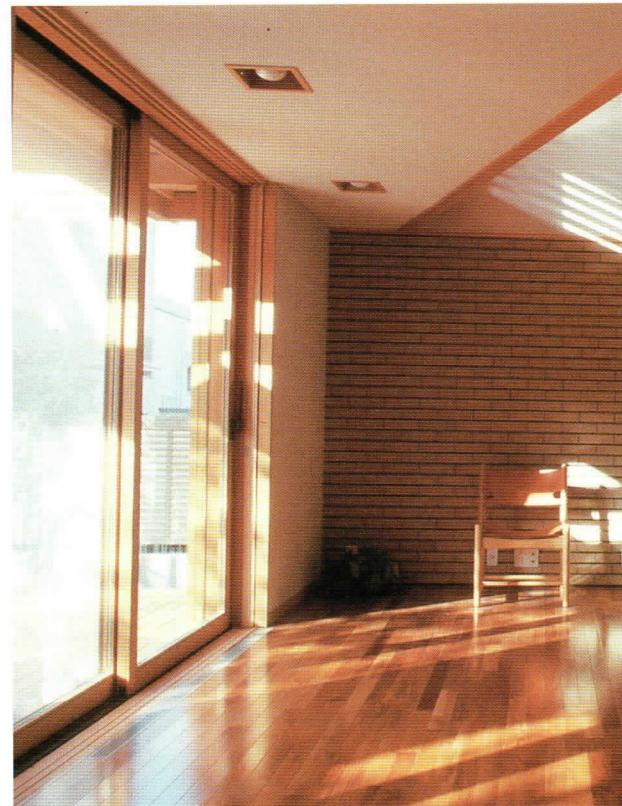
T邸居間。仕上は無垢材フローリング、ラスボード下地珪藻土、タイル、プラスチックボード下地ルルナファーザー、和紙など。合板はできるだけF1を使用するなど、HCHOの低減につとめた。冬季の測定でもあり、全体にHCHOの濃度は低いが、建具、家具などのF1でない化粧合板の使用率が高い部屋ほど濃度も高かった。
