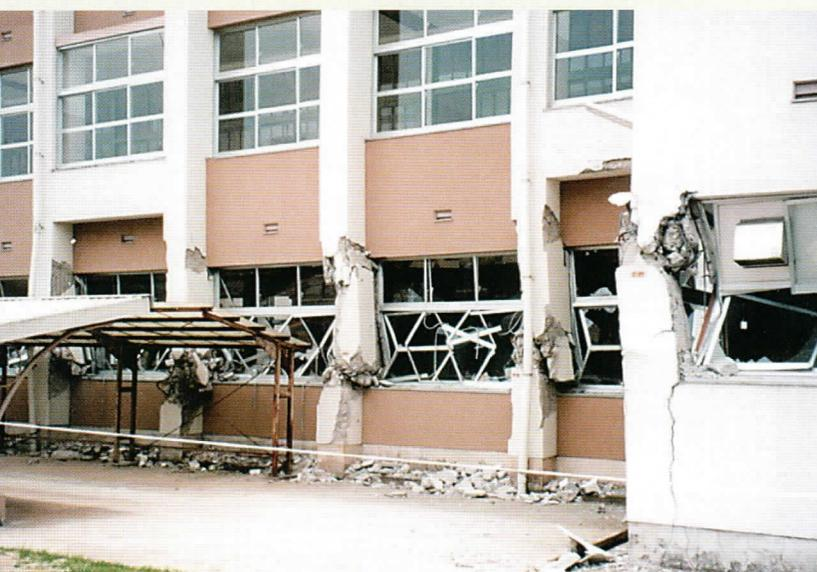
1996年鹿児島県北西部地震で著しい被害を受けた県立宮之城高校(柱と梁の軸心が大きく偏心している)
