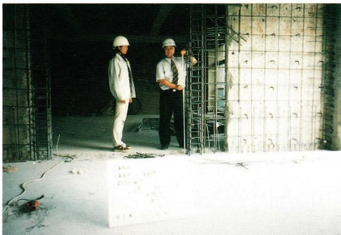
小学校の耐震改修・大規模改修の配筋検査
